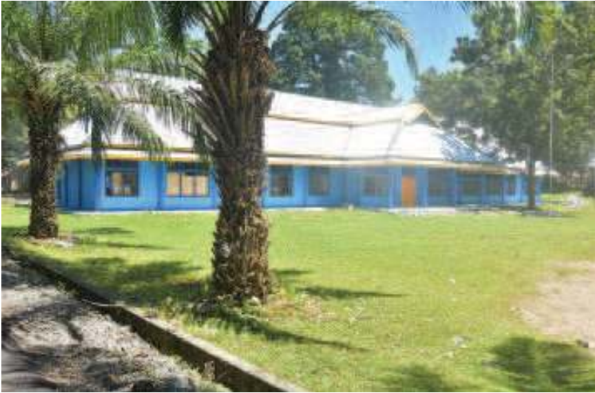
Gedung Kantor SMA Taruna Kasuari Nusantara. DOK.BALITBANGDA PB
