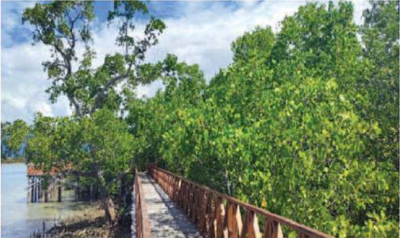
Jembatan Kormun. DOK. BRIAN AYATANOI PB
